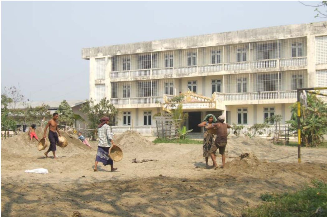
Die Höherlegung des Platzes durch Aufschütten mit Sand
