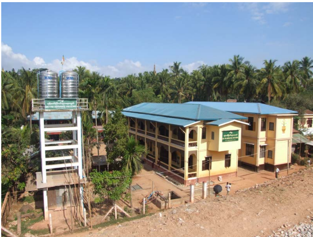
Wassertank, Schulgebäude Nr. 1 und neues Gebäude mit Küche, Ess- und Schlafsaal
