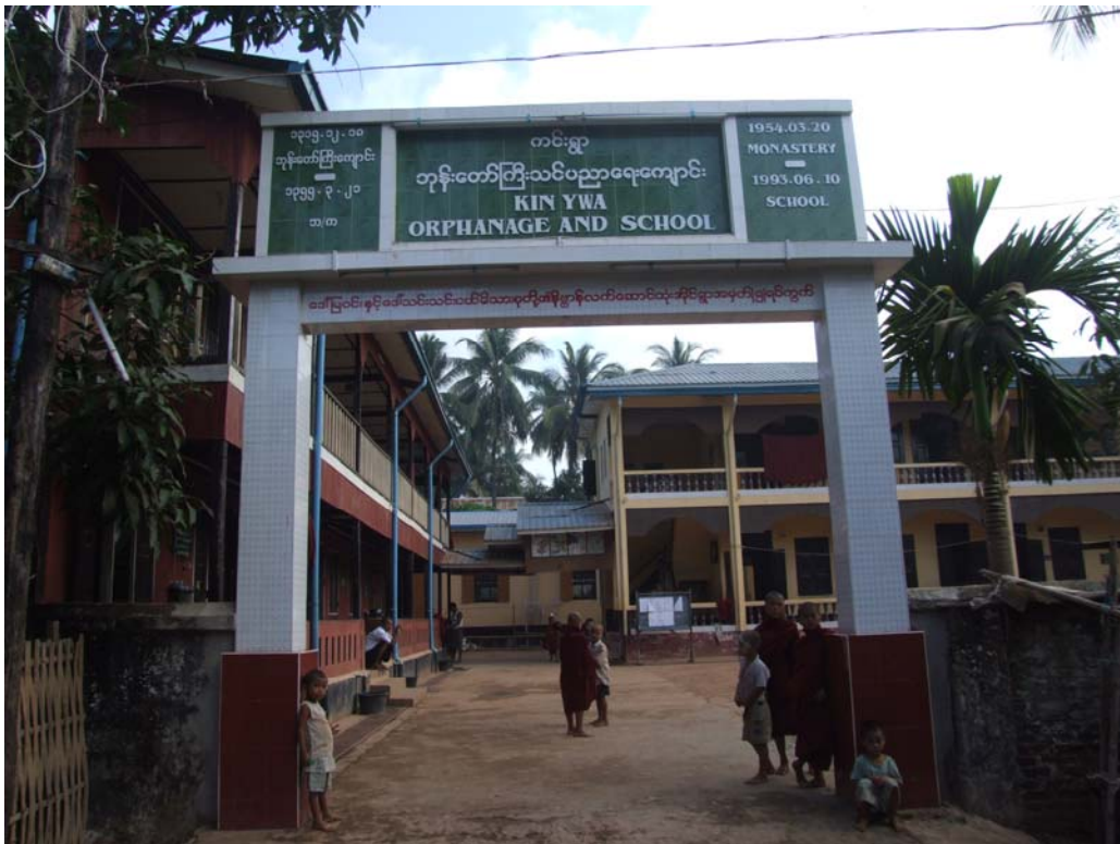
Der neue Eingang; links: Schulgebäude Nr. 2
